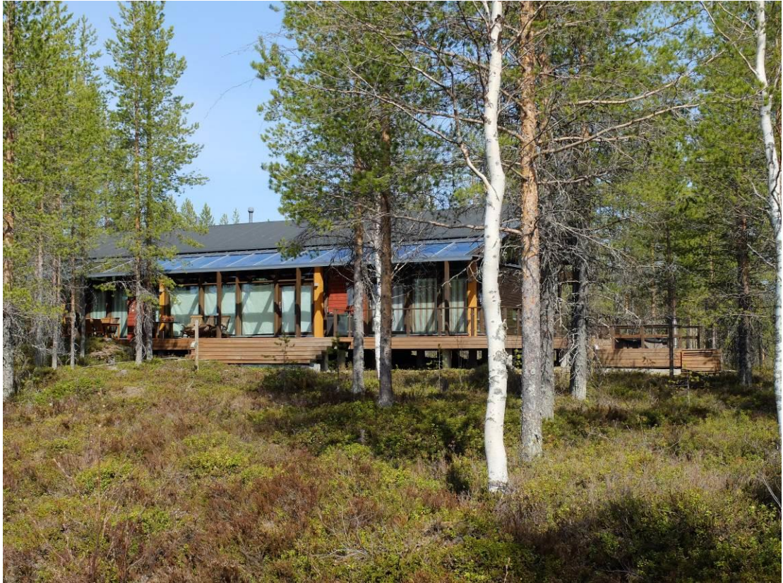
Kuva 8 Korttelin 5 uudehko päärakennus
