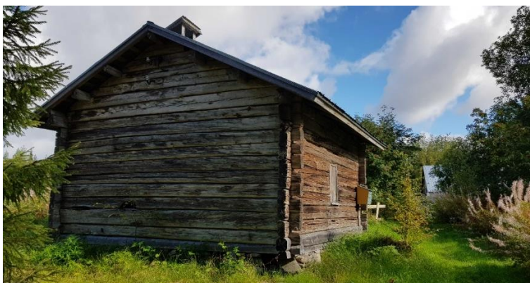
Pajan julkisivu etelään ja pääty länteen.
