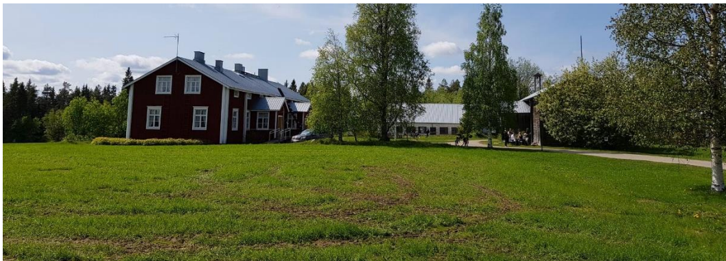
Kurimon pihapiiri. Pihapiiriä rajaavat Kurimon päärakennus, navetta ja pikkupirtti.
