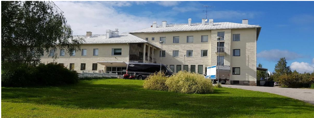
Julkisivu itään, Kurimontien suuntaan. Rakennuksessa on rapatut julkisivut ja saumapeltikatteinen aumakatto. Osa ikkunoista lienee jossain vaiheessa uusittu, todennäköisesti 1970- ja 1980-lukujen vaihteessa tehdyn peruskorjauksen yhteydessä, osa lienee jopa alkuperäisiä – toisessa ja kolmannessa kerroksessa ikkunoiden puitteet on maalattu vaaleiksi, ensimmäisessä kerroksessa tumman ruskeiksi.
