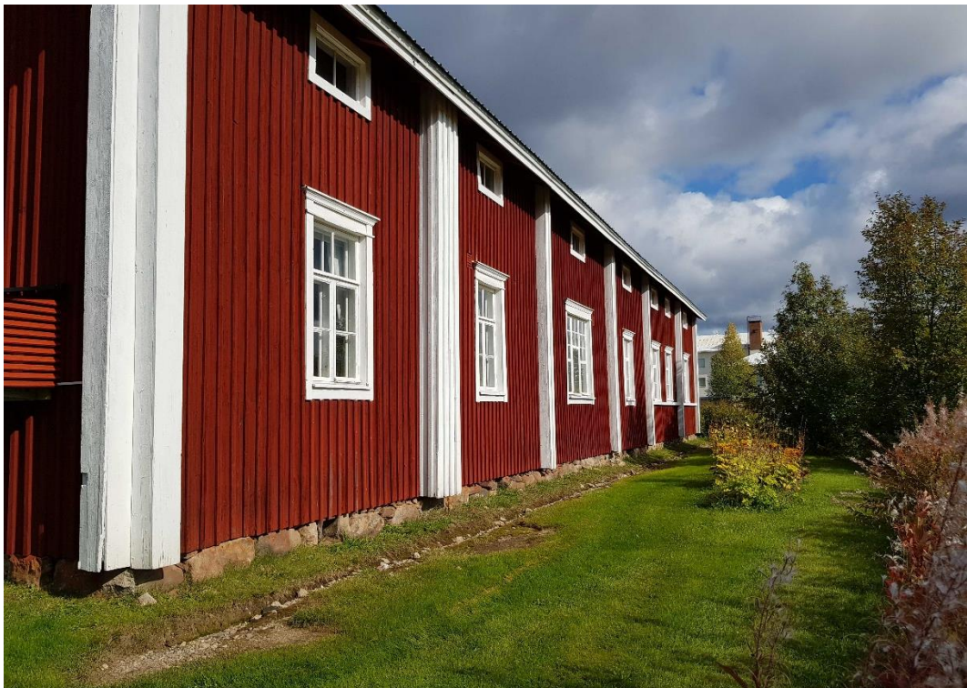
Julkisivu etelään. Rakennuksessa on pystyrimalaudoituksella vuoratut julkisivut. Nurkat on koteloitu. Pirtin leveä ikkuna näkyy nykyisen kaltaisena vanhassa valokuvassa, joten se lienee vähintään kunnalliskodin aikainen.
