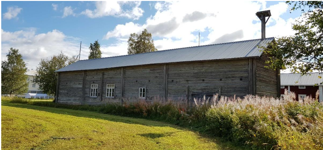
Pikkupirtin julkisivu pohjoiseen.
