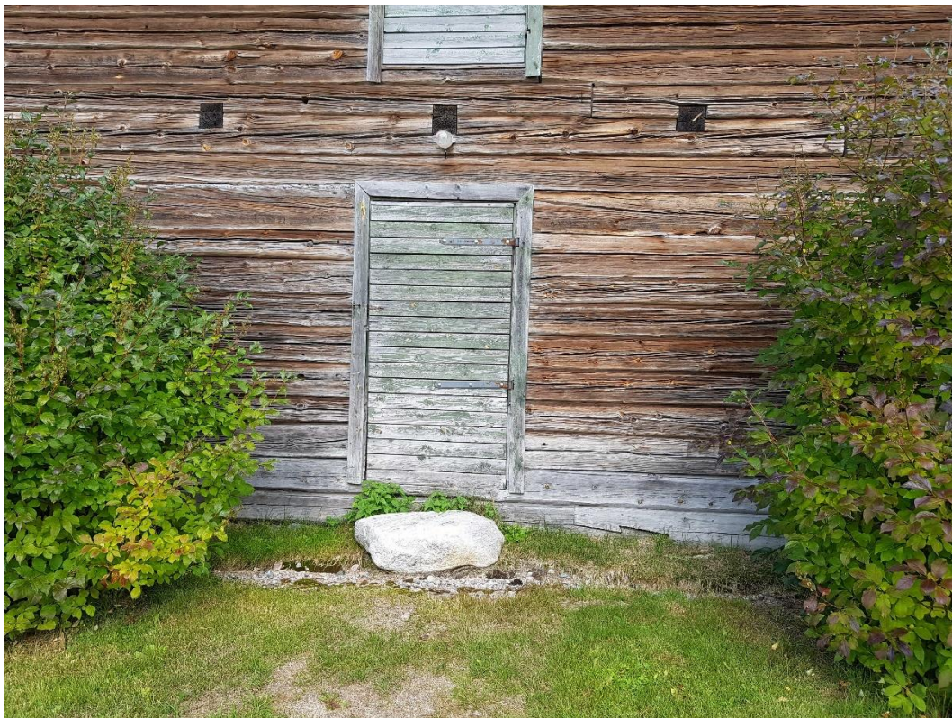
Pikkupirtti kertoo hienolla tavalla 1800-luvun lopun rakentamisen perinteestä.
