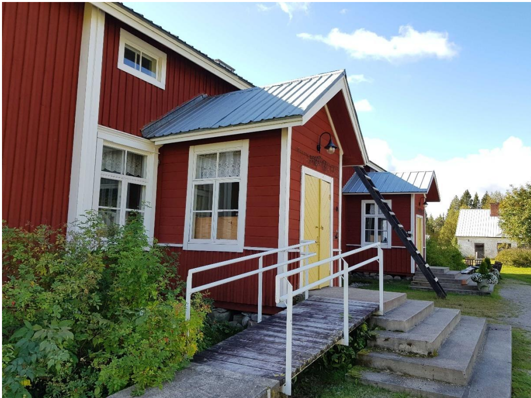
Pihan puolella on kaksi kuistia. Kuvassa taaempänä näkyvä oikeanpuoleinen kuisti on rakennettu alkuperäiselle paikalleen 1990-luvulla.
