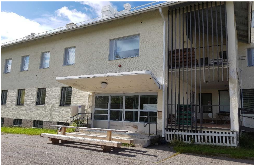
Hoitokoti Kurimon pääsisäänkäynnin yllä on sirolinjainen katos. Sisäänkäynnin ovet lienee uusittu, oletettavasti 1970-luvun lopulla tehdyn peruskorjauksen yhteydessä. Julkisivujen pintakäsittely on aikakaudelle tyypillinen. Julkisivujen alaosissa kellarikerroksen kohdalla on karkea terastirappaus. Ylemmissä kerroksissa rappauspinta on harjattu ja vaaleaksi maalattu. Ikkuna-aukkoja ympäröivät kapeat sileiksi rapatut kehykset.
