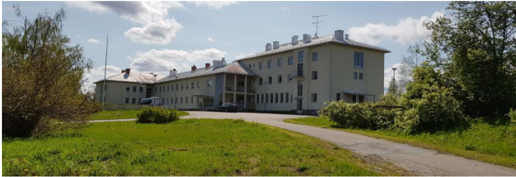
Vanhainkoti, julkisivu Kurimontien suuntaan. Mäellä sijaitseva rakennus erottuu tielle maamerkkirakennuksena.
