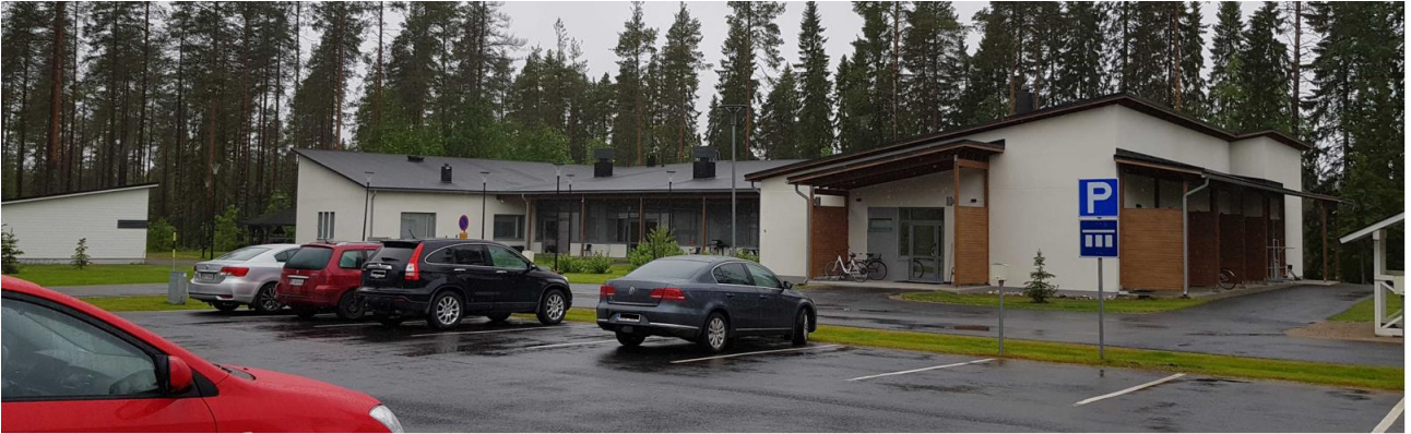
Kuntoutuskoti sijaitsee terveyskeskuksen länsipuolella Koksarinkujan päässä.
