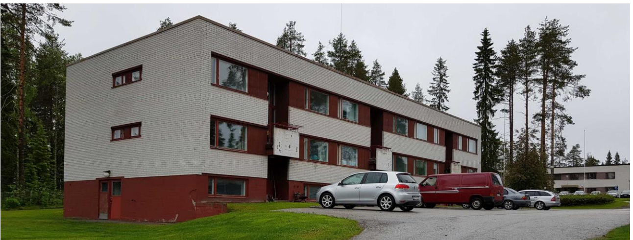
Suomussalmen perhekeskuksen länsipuolella sijaitseva kerrostalo on suunniteltu purettavaksi pois uuden terveysaseman tieltä. Rakennuksessa on todettu laaja kosteusvaurio.
