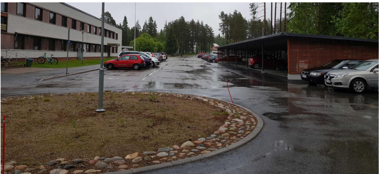
Hoitokoti Jalonkosken edustalla on kääntöympyrä. Pysäköintialueella on myös autokatos.
